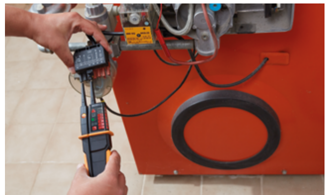
Wykrywanie błędów w układzie grzewczym za pomocą testo 750 .
