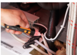
Wstępny test napięcia zasilania na sprzężarce.
