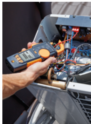
Pomiar miernikiem cęgowym na zewnętrznym klimatyzatorze.
