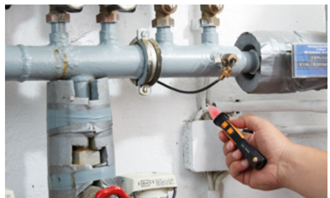
Wykrywanie napięcia w skrzynce rozdzielczej z testo 745 .
