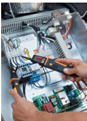
Pomiar napięcia na sprężarce.
