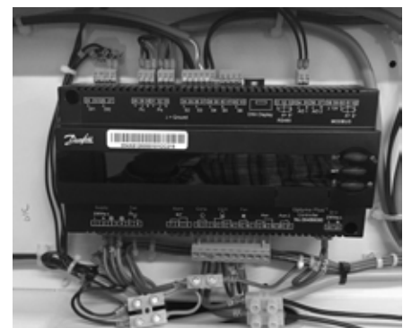
Billede 4: Midlertidig ledningsføring
