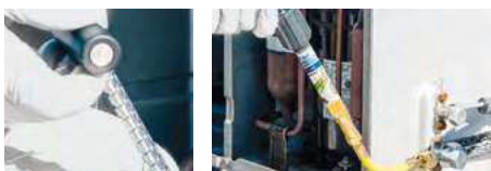
Wprowadzanie barwnika za pomocą dozownika
