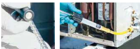
Wprowadzanie uszczelnacza za pomocą dozownika.
