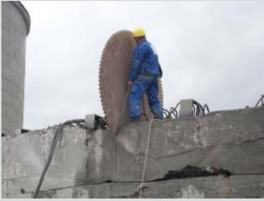
Cięcie piłą ścienną
