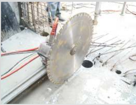
Cięcie piłą ścienną
